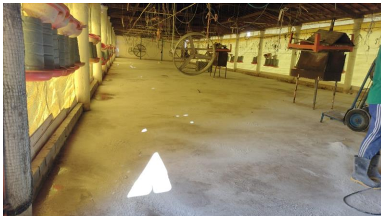
Figura 8: Galpão já aplicado cal.
