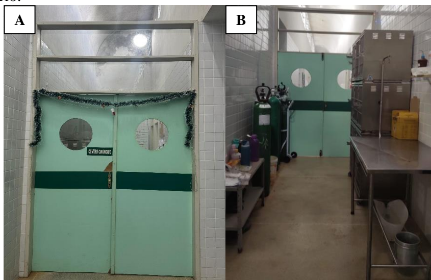
23 24 25 26 27 28 29 30 31 32 33 Figura 3: Centro Cirúrgico do setor de CCPA - UFPB. A – Entrada do Centro 34 Cirúrgico; B – Área de preparação do paciente. 35 Fonte: Setor de Clínica Cirúrgica de Pequenos Animais UFPB – Campus Areia (2025)
