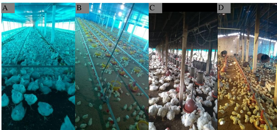
Figura 42- Tipos de Galpões utilizados para alojar aves Pressão negativa(A) Pressão positiva (B) Semi-climatizado (C) Convencional (D)
