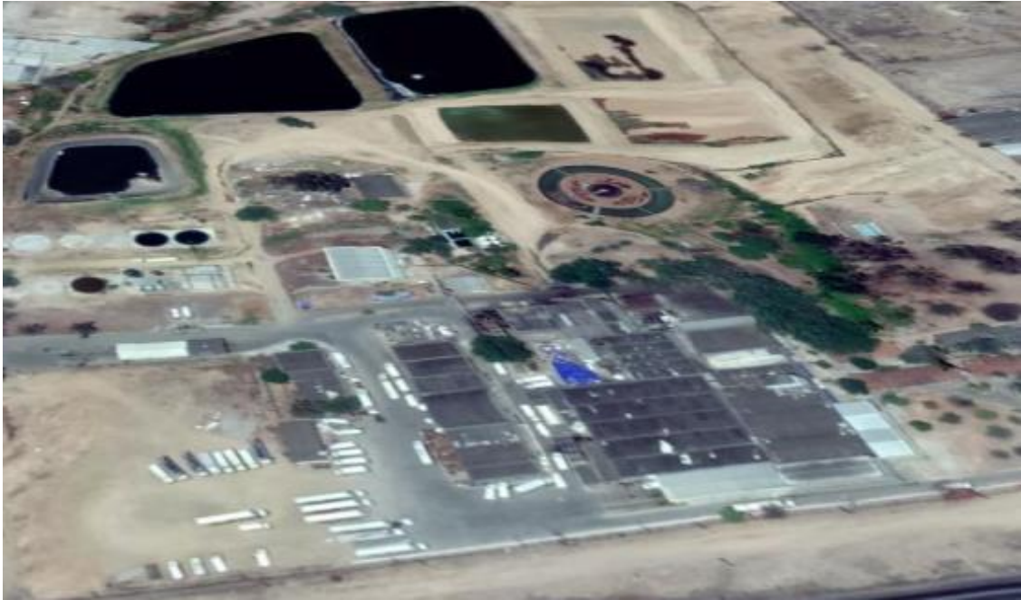
Figura 4- Abatedouro de aves – Belo Jardim-PE
