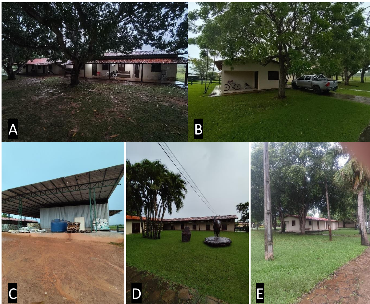
1 FIGURA 6: Alojamento (A), casa do veterinário Matheus (B), Galpão da ração (C), Haras (D) e refeitório (E).
