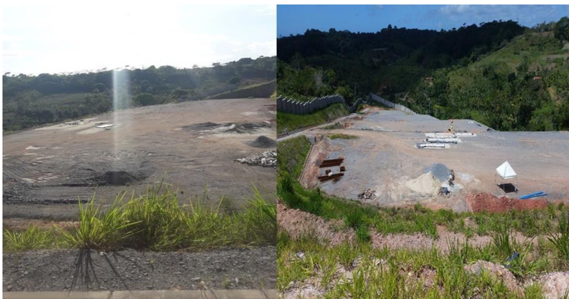
Figura 4: Canteiro de obra onde será instalada na usina fotovoltaica. Fonte: CITAR, 2017.
