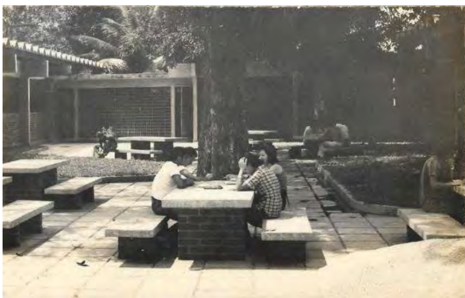
BIBLIOTECA CENTRAL - SALAS DE ESTUDO - "CAMPUS" DA UFRPE - RECIFE - PE.
