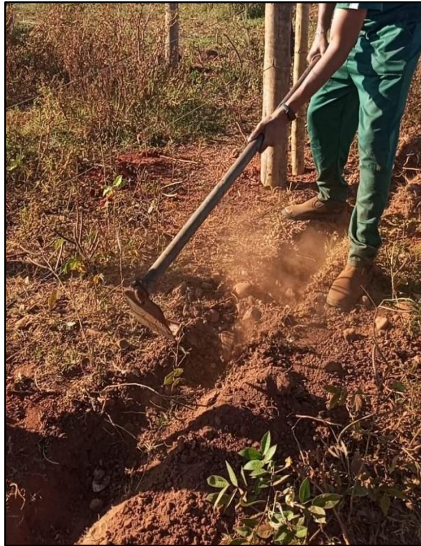
Figura 8. Via da tubulação.
