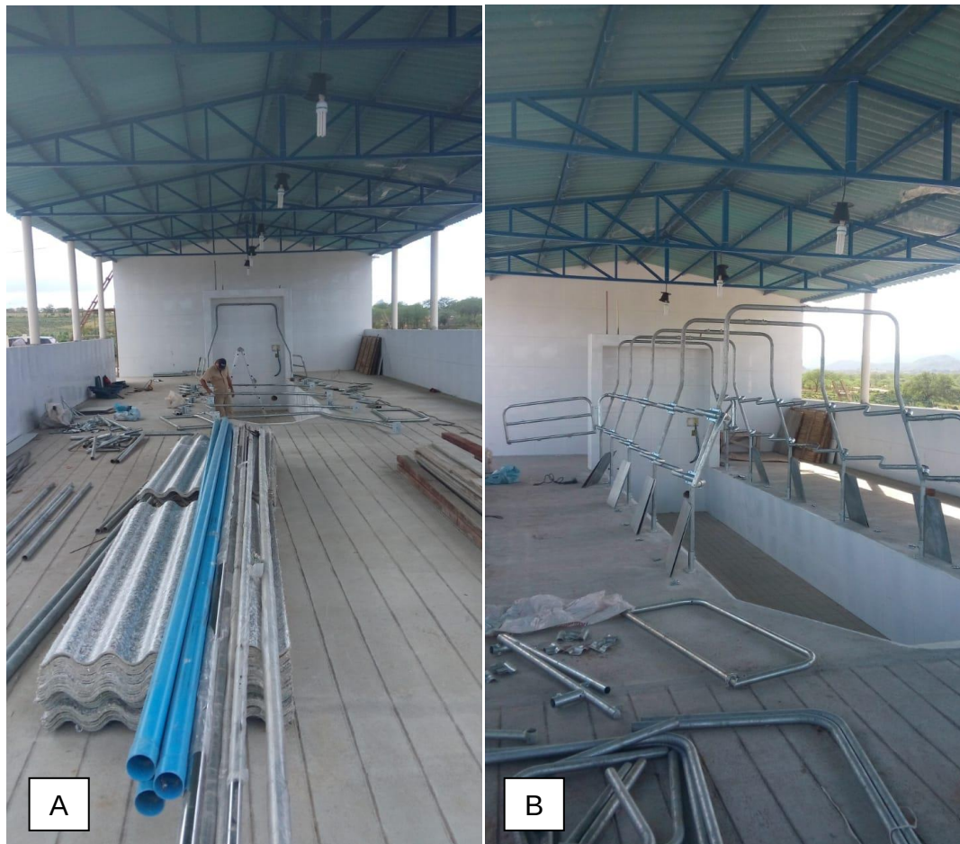
Figura 3: Instalação de equipamento na fazenda São José localizada em Sapé-PB, (A), contenção já montada (B).
