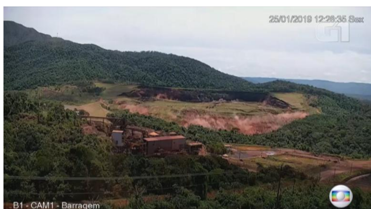
Figura 7: Rompimento da Barragem em Brumadinho.
