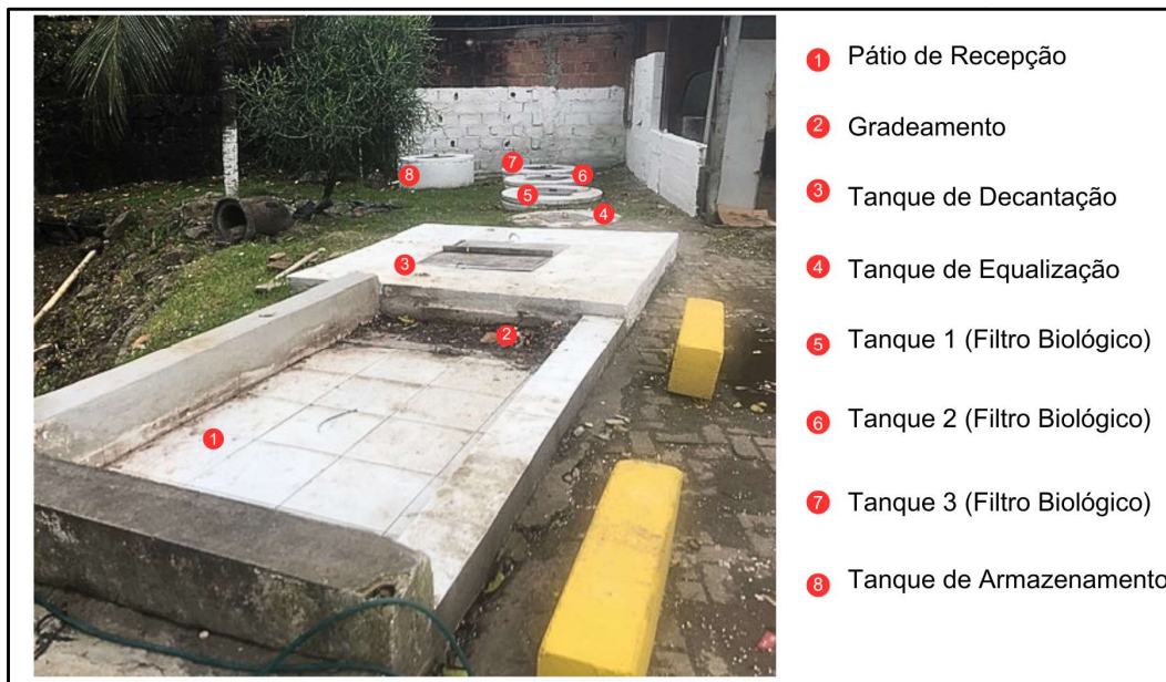
Figura 2: Sistema de Filtro Biológico (SFB).
