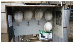
Figura 5 – Painel para suporte de EPI's fabricado com madeira reaproveitada da obra.
