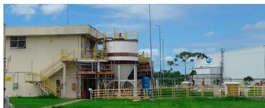
Figura 1 – Estação de Tratamento de Efluente Industrial (ETEI).
