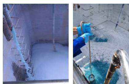
Figura 10 – Esgoto bruto com espumas não naturais resultante do AD.
