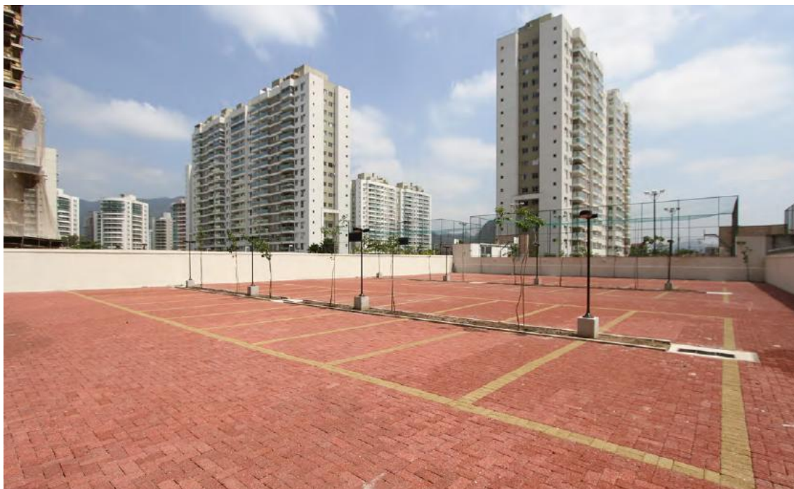
Figura 2 – Pátio de condomínio com pavimento intertravado permeável
