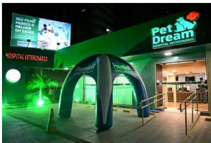
Figura 10. Fachada da Unidade de Piedade
