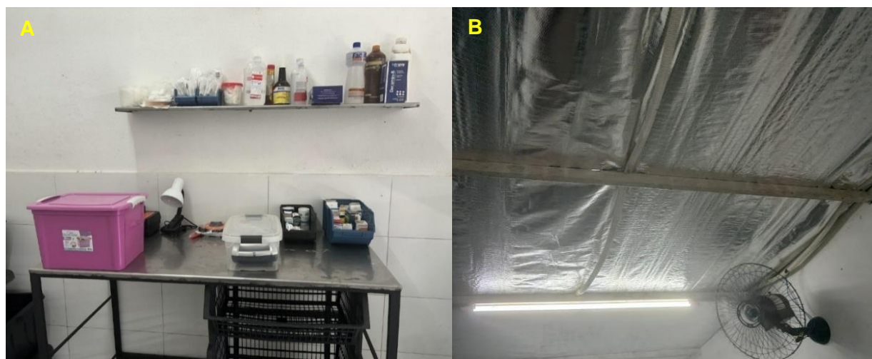
Figura 7. Maternidade do canil. A: Estrutura da maternidade equipada com mesa em aço inox, materiais e medicamentos. B: Detalhe do ventilador instalado no teto e do revestimento antitérmico utilizado na sua cobertura.
