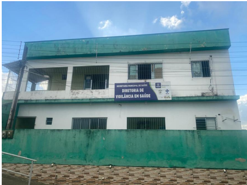
Figura 1- Fachada da sede da vigilância em saúde
