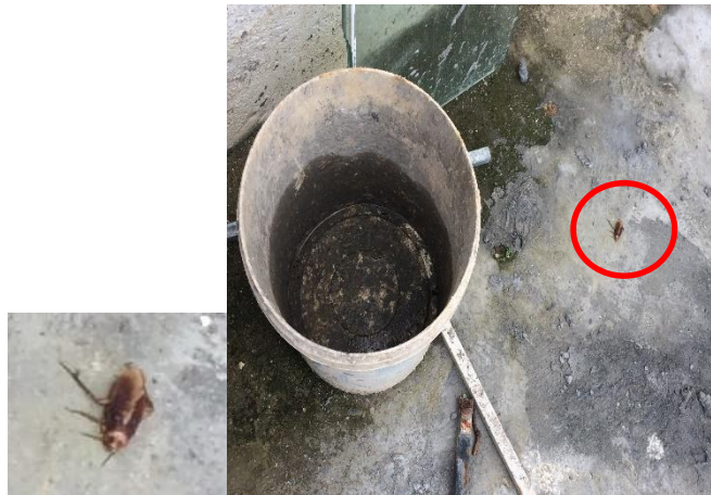
Figura 51: Presença de insetos.
