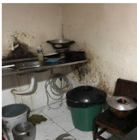
Figura 18: Falta de higiene e lixeiras inadequadas.
