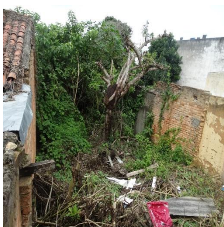
Figura 2: Início da limpeza do terreno.
