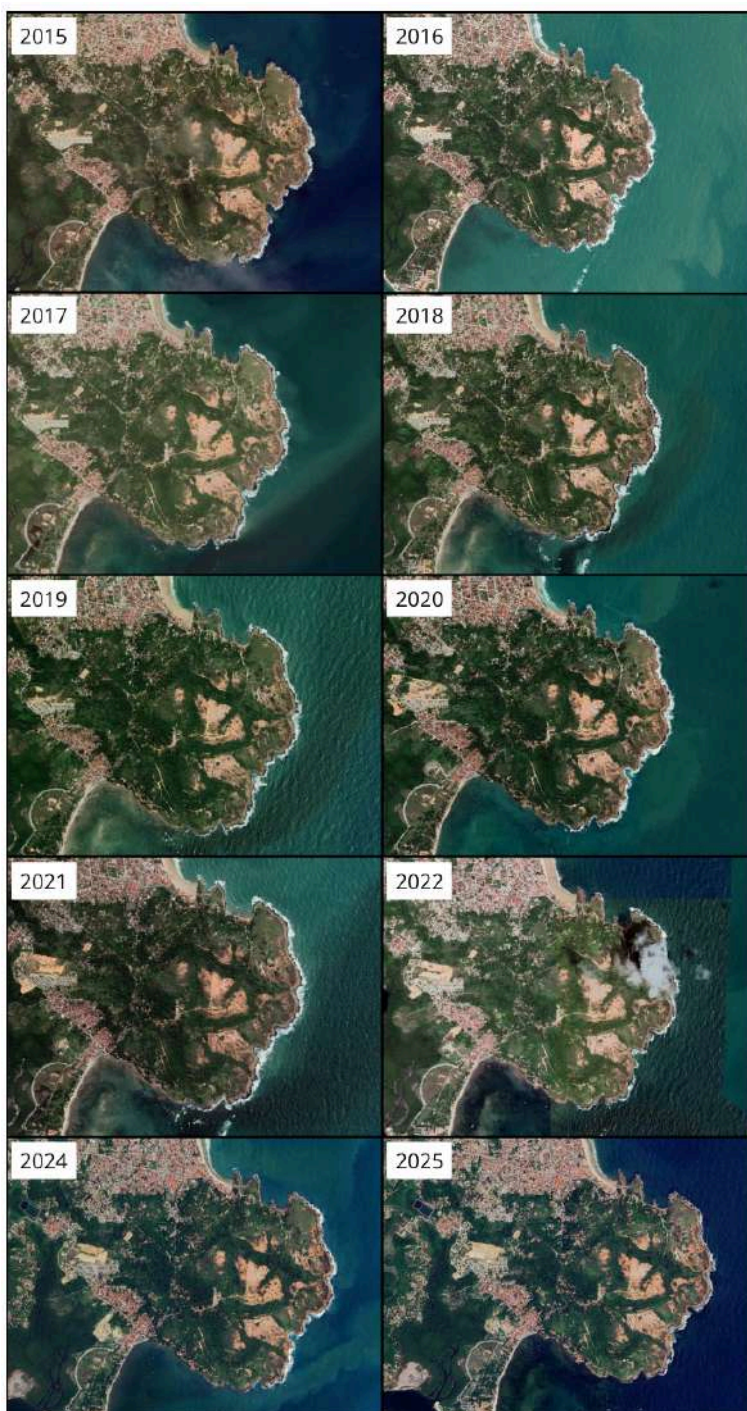
Figura 16 - Comparativo em intervalo de 10 anos da cobertura vegetal e processos erosivos.
