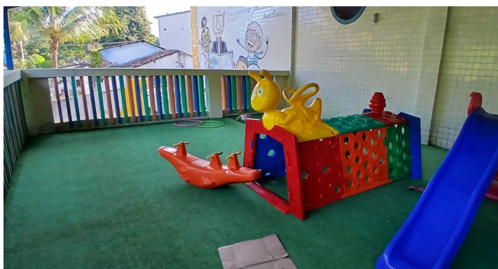
Fotografia 15: vista para mureta de proteção
