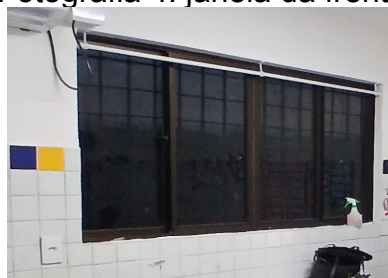
Fotografia 4: janela da frente
