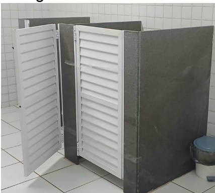
Fotografia - 24: cabines sanitárias comuns
