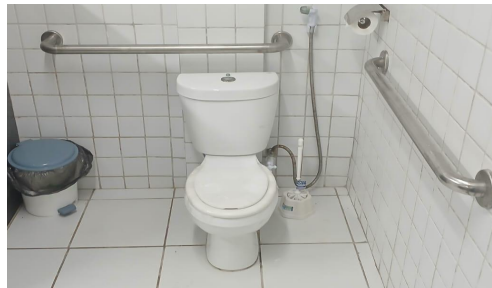
Fotografia 23: banheiro para crianças com deficiência motora
