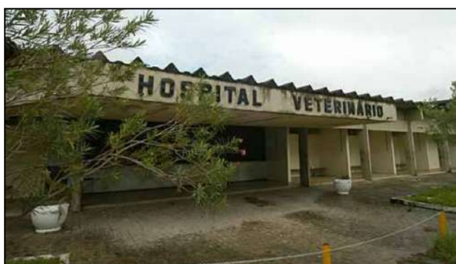
Figura 12. Fachada do Hospital Escola Veterinário da Universidade Federal Rural de Pernambuco.
