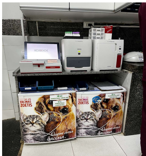
Figura 16. Frigobares de armazenamento de alimentos e de coletas e máquinas de exames. Fonte: A autora, 2025.
