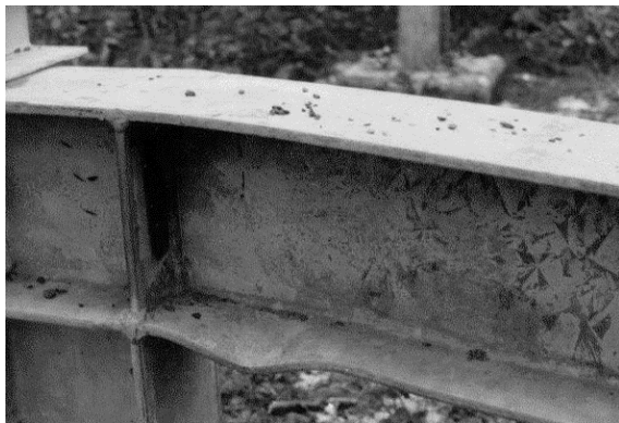
Figura 4 – Flambagem local perfil I
