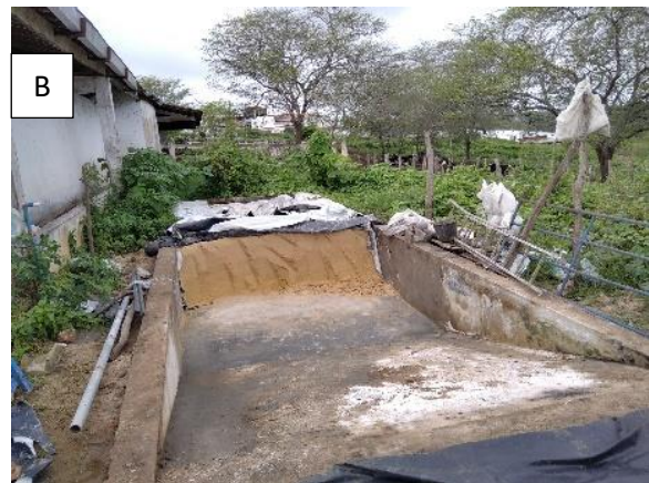
Figura 6: (A) Silos do tipo trincheira com capacidade de 37,5 toneladas cada, (B) Silo do tipo trincheira com capacidade de 22,5 toneladas.
