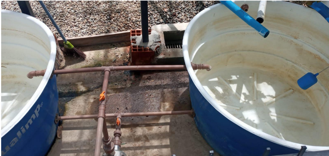
Figura 4 - Caixas d'água de 500L após a limpeza. (Fonte: Arquivo pessoal, 2024).
