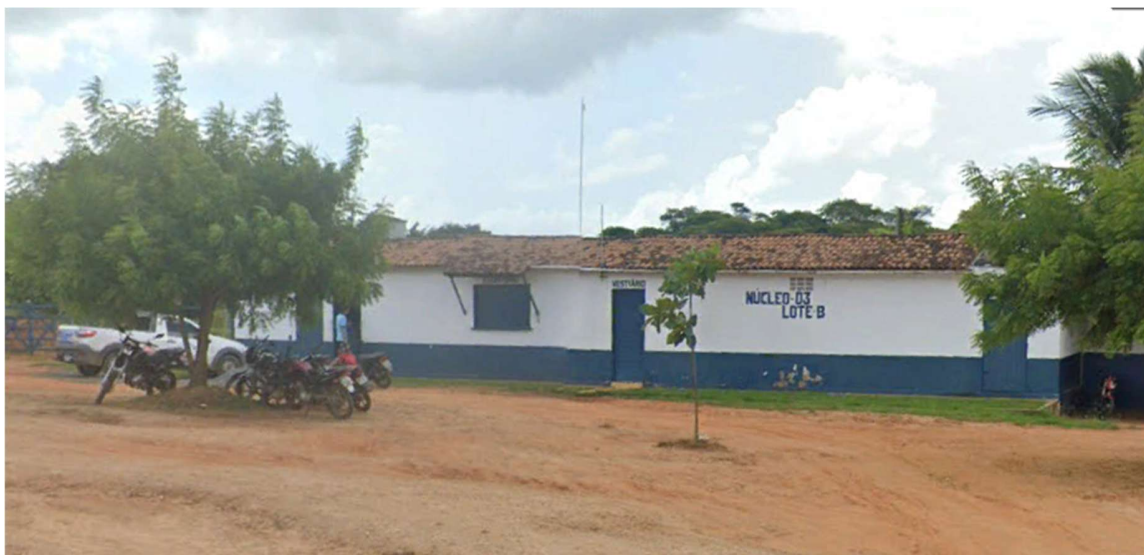
Figura 2– Entrada da granja de matrizes reprodutoras pesadas – Sertãozinho PB. Fonte: Google Street View, 2024.
