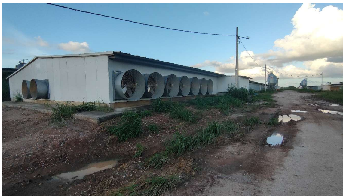
Figura 35 – Sistema de exaustores de aviário comercial do tipo dark house . Fonte: Arquivo pessoal, 2024 (Autorizado pela empresa).
