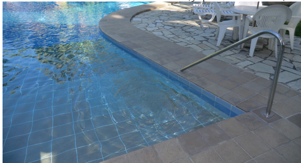
Figura 13 – área da piscina cercada por escadas
