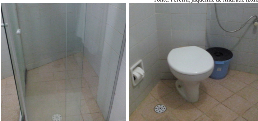
Figura 6 e 7 – Banheiro sem acessibilidade em hotel de médio porte
