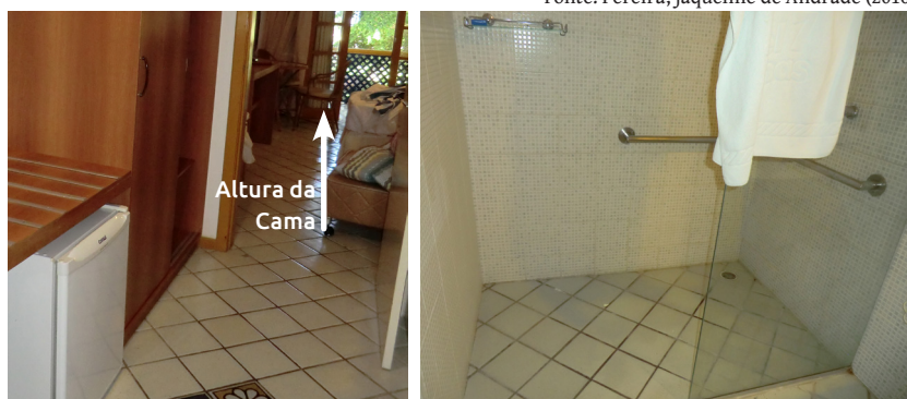
Figura 8 e 9 – Área de circulação da Uh pequena e Banheiro da Uh sem cadeira de banho
