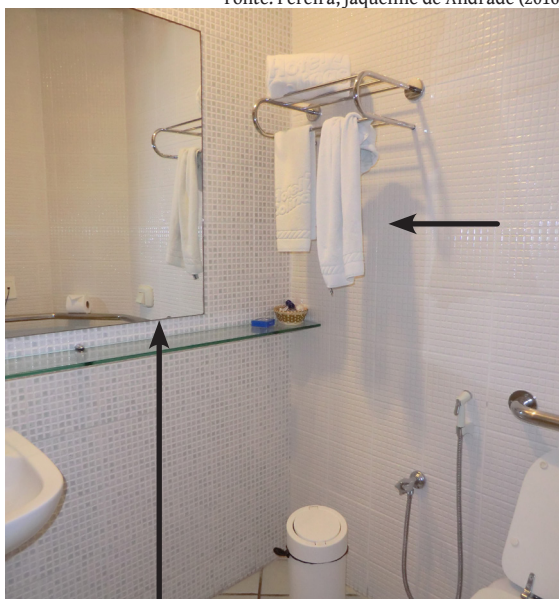
Figura 10 - Banheiro de hotel UH com espelho e toalhas fora de alcance
