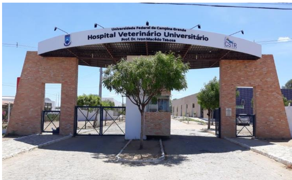
Figura 1 - Fachada do Hospital Veterinário Universitário da UFCG. Fonte: Gonzaga (2019).
