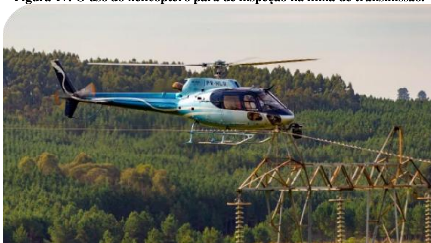
Figura 17: O uso do helicóptero para de inspeção na linha de transmissão.
