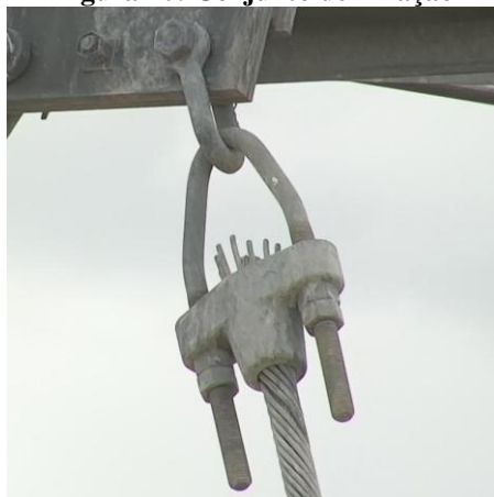
Figura 10: Conjunto de Fixação
