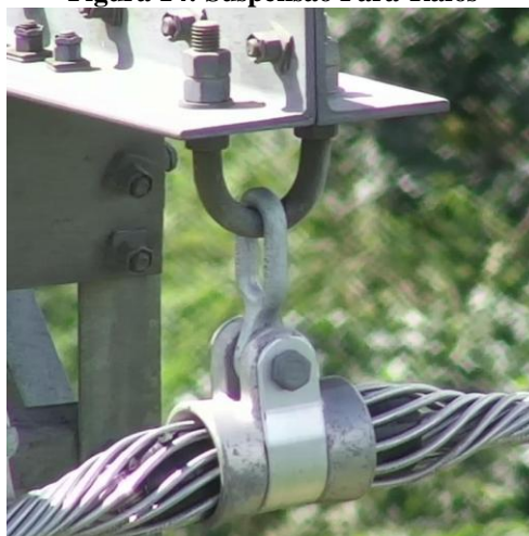
Figura 14: Suspensão Para-Raios
