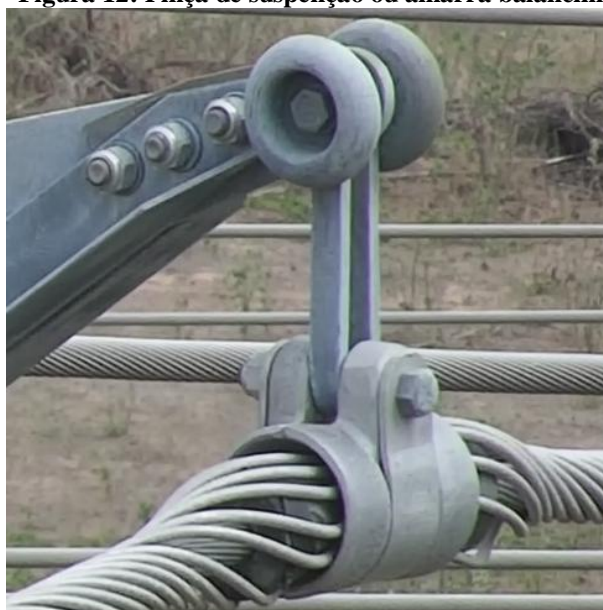
Figura 12: Pinça de suspensão ou amarra balancim
