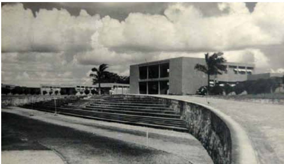
Foto 17 - Em destaque, as palmeiras imperiais, ladeando o bloco central. Observa-se, também, a arquibancada para acesso ao campo de futebol. Fonte: Coleção Secretaria de Educação ao Menor. Arquivo Público Estadual Jordão Emerenciano. Reprodução fotográfica: Juliana Leitão
