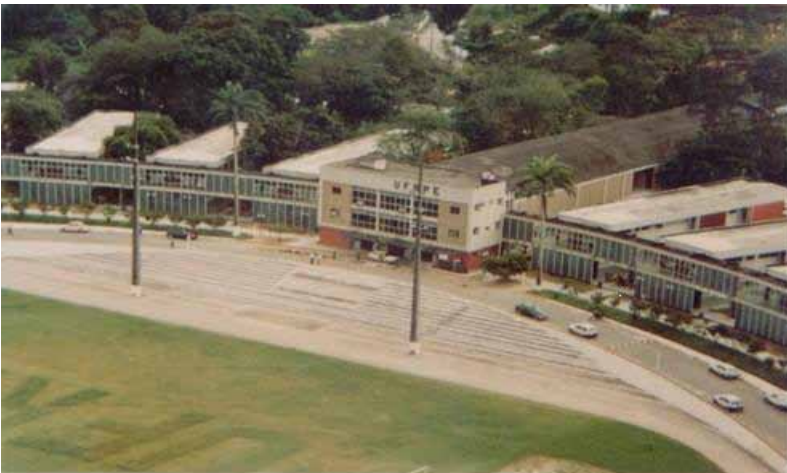
Foto 22 - Visão aérea do conjunto. Fonte: Coleção de Fotografias da Coordenadoria de Comunicação Social – UFRPE.
