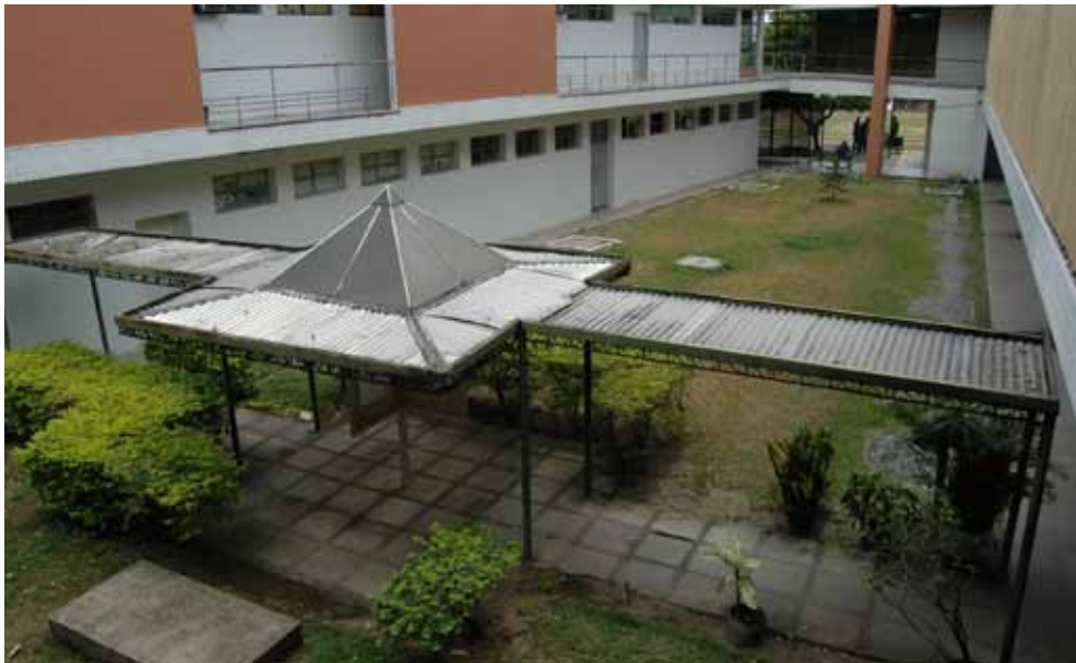
Foto 43 - Detalhe de uso do espaço entre dois blocos da ala esquerda, tendo ao fundo a passarela do bloco central. Fotografia: Juliana Leitão
