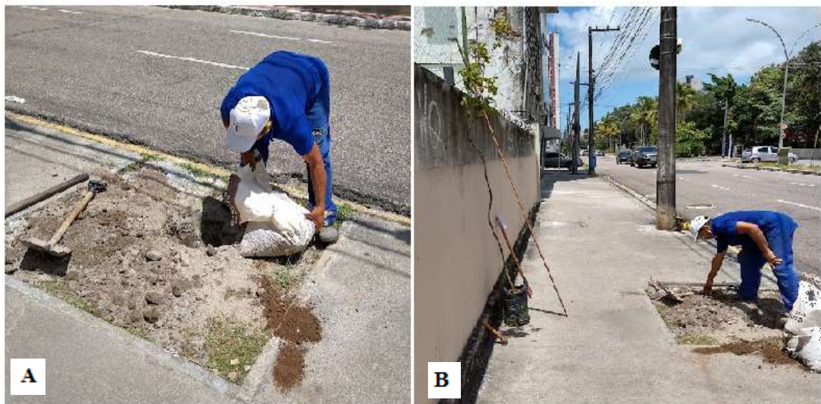
Figura 5 -Imagens do preparo dos berços na Av. Mário Melo.
