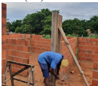
Figura 9 – Execução das Unidades Habitacionais (UH) com mão de obra local
