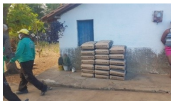
Figura 8 – Armazenamento de materiais
