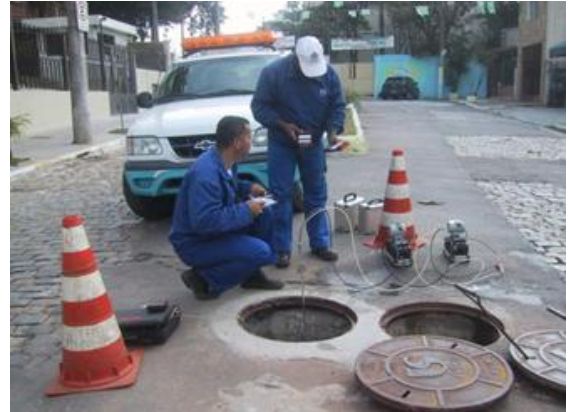
Figura 10 - Profissionais calibrando macromedidor.
