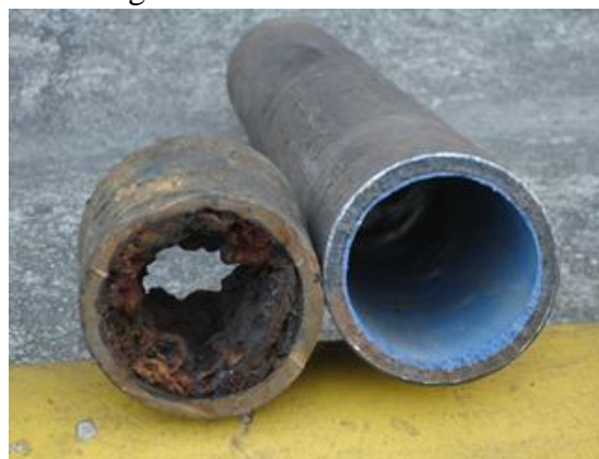
Figura 11 - Comparativo entre um trecho de rede antigo e outro reabilitado.
