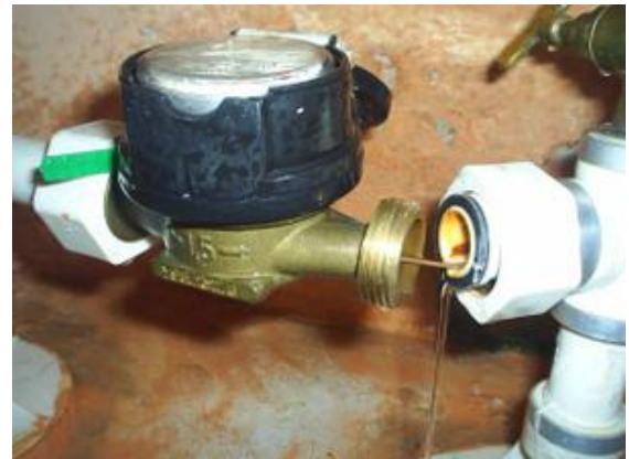
Figura 4 - Fraude em hidrômetro com arame.
