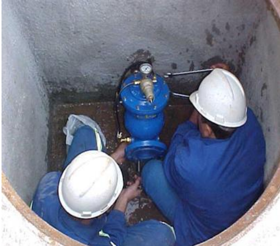
Figura 9 - Instalação de uma válvula redutora de pressão.
