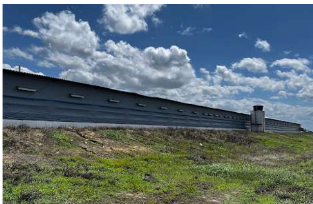
Figura 56. Galpão de pressão negativa visto de fora
