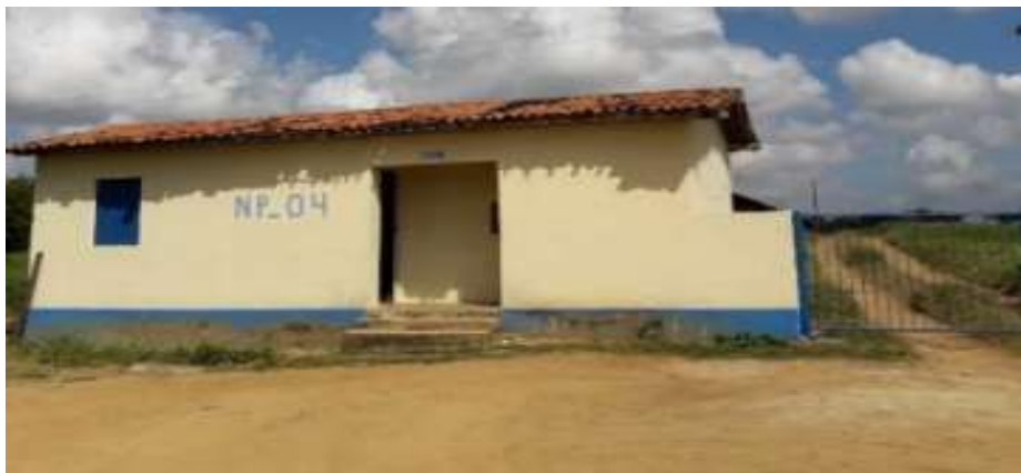
Figura 38. Entrada do núcleo Fonte: Mauricéa Alimentos do Nordeste LTDA
