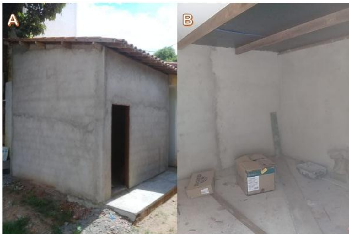
FIGURA 27: Ampliação do LPU - URCA: A) Fachada de acesso a porta da futura sala de preparação de fósseis. B) Área interna em processo de construção/acabamento. Fonte: João Silva, (2018).
